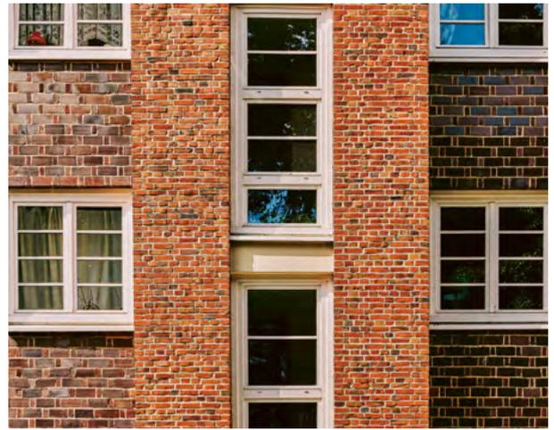
31 Die rötlichen bis dunkelvioletten Farbtöne der Backsteine entstehen durch den Brennprozess, bei dem sie über längere Zeit hohen Temperaturen von 1100–1300°C ausgesetzt sind. Durch die Hitze verdichten sich die Tonpartikel und verschmelzen teilweise, wodurch eine besonders widerstandsfähige und wetterfeste Oberfläche entsteht – ein Prozess, der *sintern* heißt.
